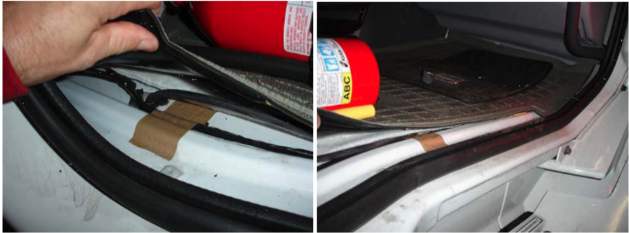
Figure 11 : Exemple de placement de câble dans une cabine de véhicule
